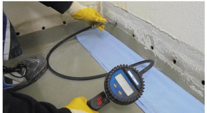
Optional kann die Bohrreihe schachbrettförmig gesetzt werden, wenn Sie eine Flächensperre erzeugen wollen und eine flächige Trockenlegung des Mauerwerks erreicht werden soll. SF-HIK 25 eignet sich für alle mineralischen Mauerwerke und erzeugt ein besonders gutes Ergebnis, wenn Sie die Injektion bei Ziegelsteinmauerwerken, Beton, Naturstein oder Bruchstein, Kalksandstein sowie Gas-Beton oder Hohlkammersteinen vornehmen lassen.
